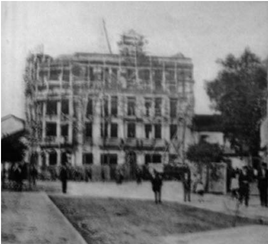
La «Casa do Escobeiro» en construcción.
